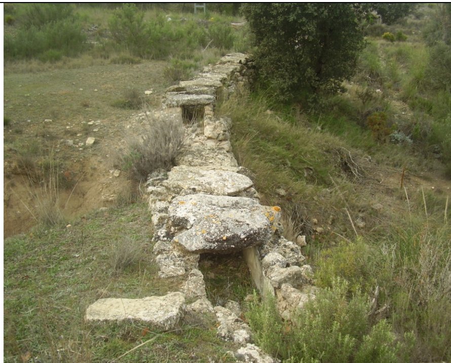
Fuente del Regajo 2. Acequia cubierta de losas (13-12-2009)
