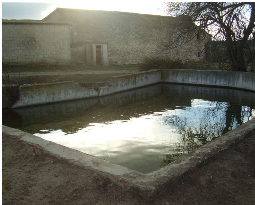
Fuente Casa de las Monjas 2. Balsa y Casa de las Monjas (25-2- 2013)
