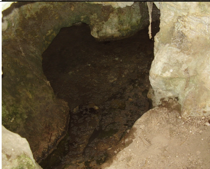
Fuente Casa de las Monjas 3. Interior de la bocamina (25-02- 2013)
